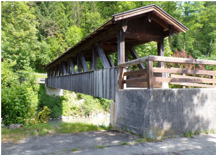
Abbildung 1: Holzbrücke mit konstruktivem Holzschutz
